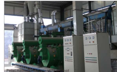
非洲埃及设备安装现场
