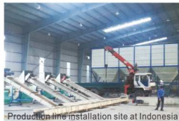
印度尼西亚生产线安装现场
